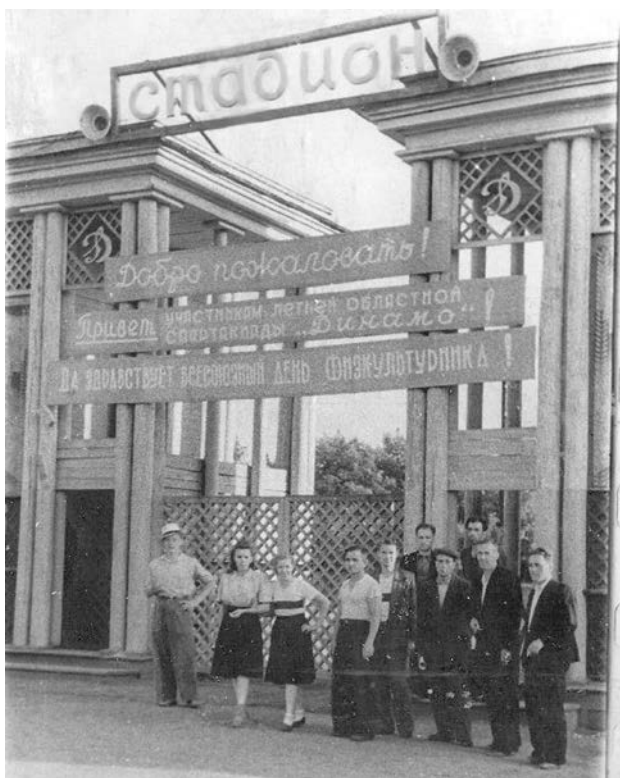
Центральный вход на стадион «Динамо», г. Пермь
